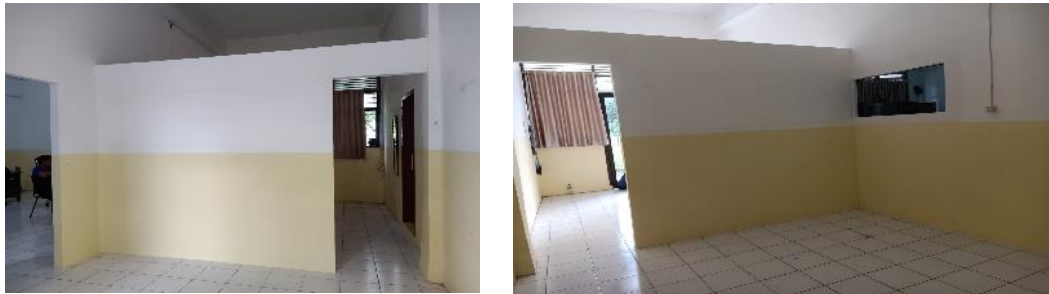
Gambar 6. Renovasi Gedung Bangunan Kelas Tahun 2022
