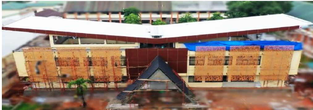
Gambar 5. Reaslisasi Renovasi Gedung Sekolah (Bangunan Kantor)
